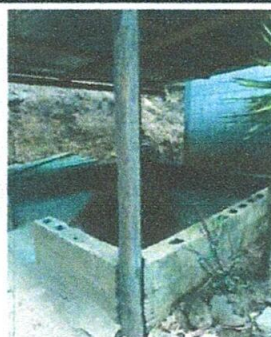
Foto 4: Mejormiento De Galera Para Pila
