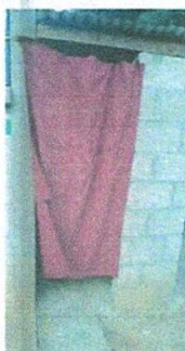
Foto1: Instalacion De Puerta
